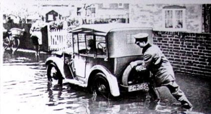
Strážník silniční služby pomáhá automobilistovi ve vlně po náhlé zátopě
